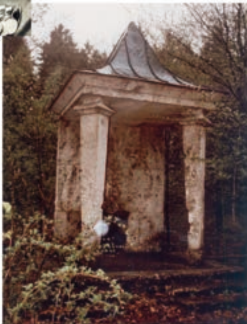
Abbruch des baufälligen Denkmals 1984
